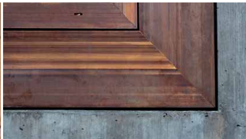
Schulhaus, Paspels (CH)
